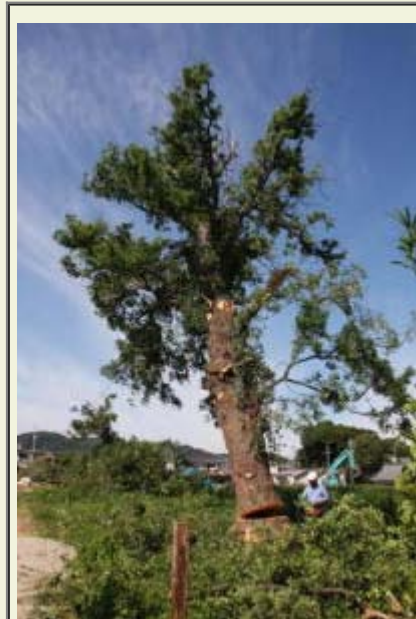
切り倒される「ナギの大木」＝蒲郡市大塚町で（18日写す）
